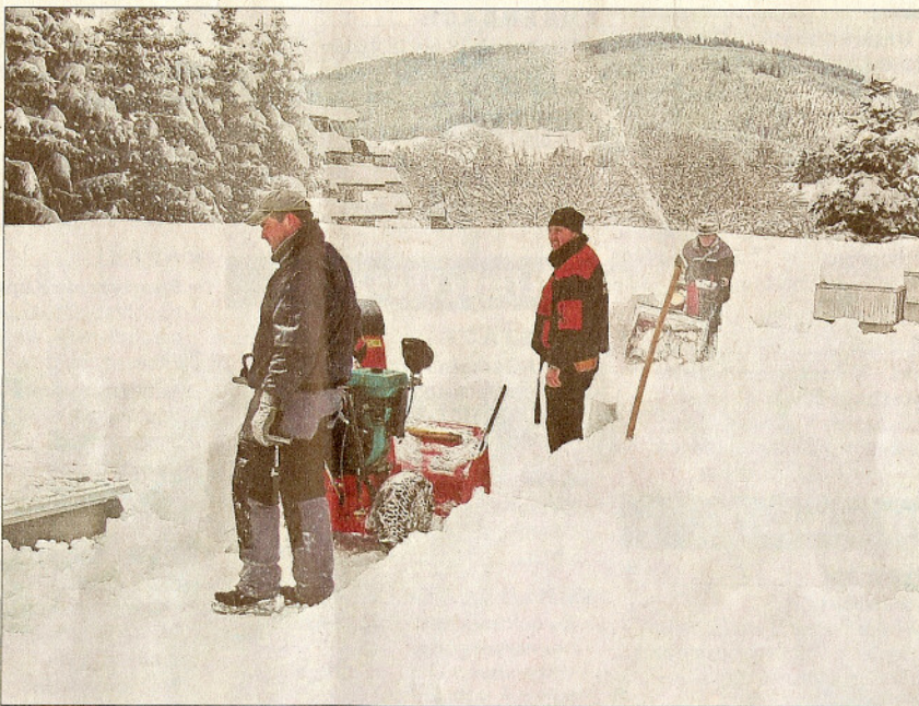
Mitarbeiter eines Dachdeckerbetriebes fräsen den Schnee vom Dach der Hebelschule. Eine Eisschicht, alter Schnee, neuerer Nassschnee und der Pulverschnee bilden eine 85 Zentimeter starke Schicht deren Gewicht fast den Grenzwert erreicht hat. Kurzfristig hatte das Stadtbauamt beschlossen, den Schnee abfräsen zu lassen.
