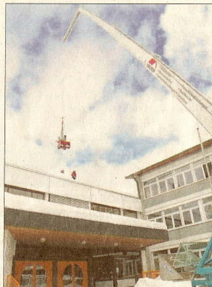
Ein Hebekran hievt die Fräsen auf das Dach der Hebelschule.
